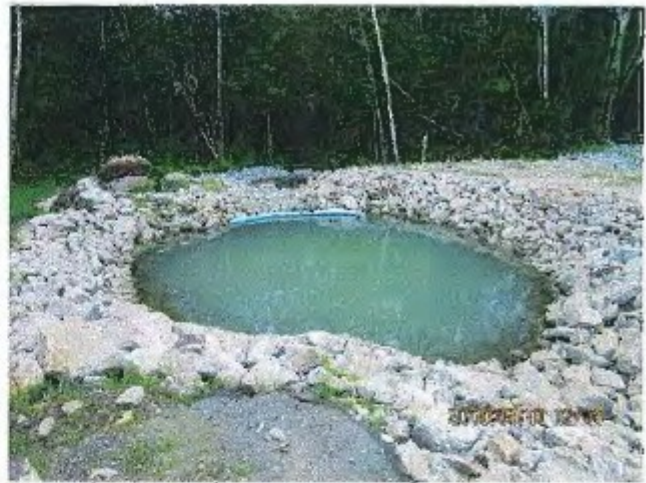
(photo 26) IMG_0318.JPG bassin de sédimentation avant rejet du fossé à la végétation
