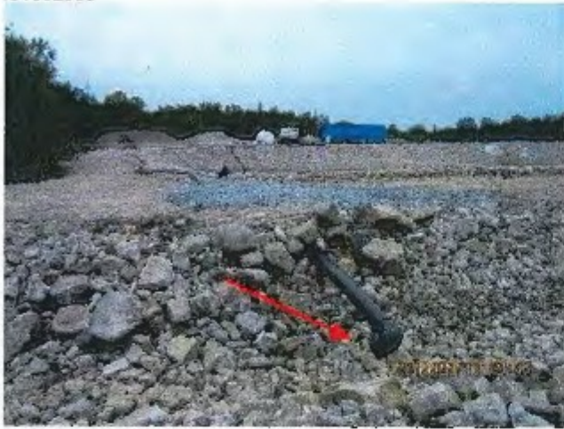
(photo 25) IMG_0317.JPG point de rejet du bassin de polissage au fossé
