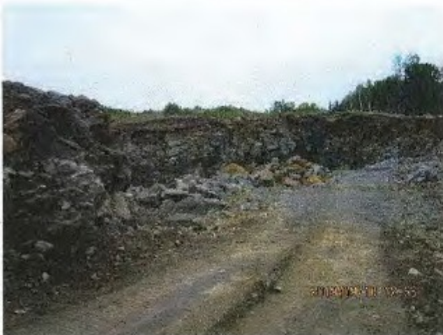
(photo 29) IMG_0326.JPG fosse d'extraction
