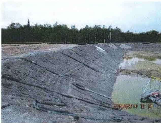
(photo 21) IMG_0301.JPG parc à résidus
