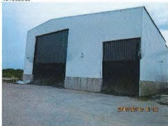
(photo 1) IMG_0288.JPG bâtiment d'entreposage du minéral concassé
