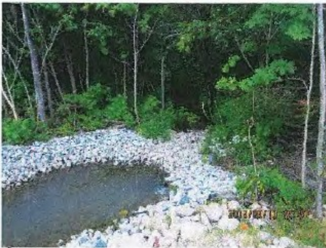
(photo 27) IMG_0321.JPG bassin de sédimentation avant rejet du fossé à la végétation
