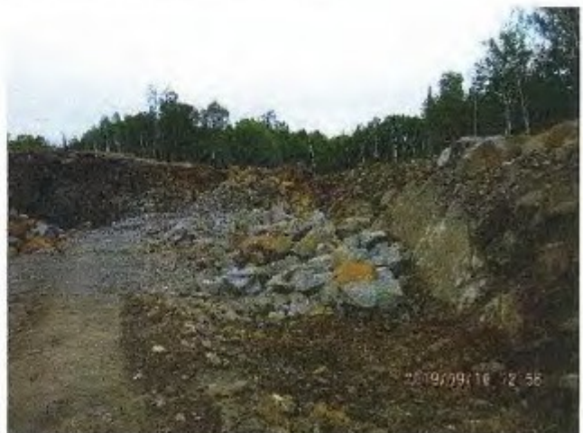
(photo 30) IMG_0327.JPG fosse d'extraction
